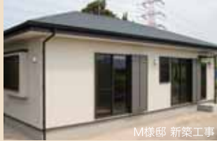
M様邸 新築工事 サイディング
