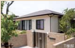
T様邸 新築工事
